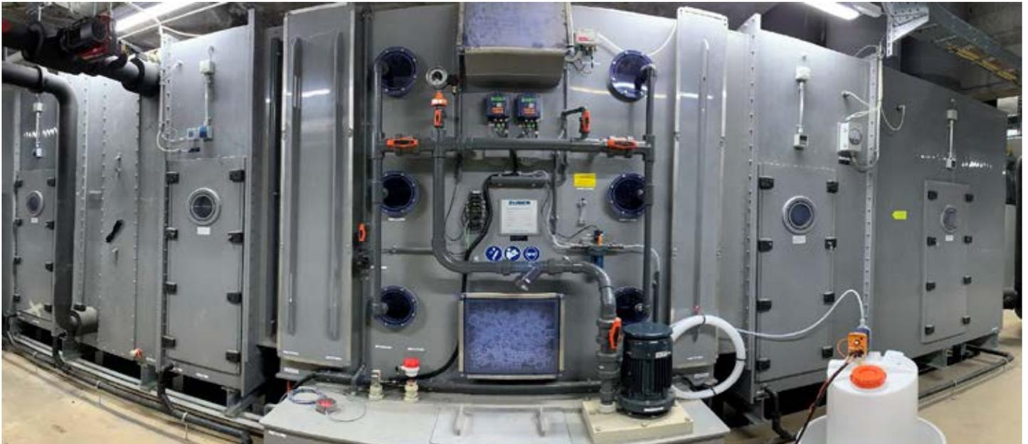
**ZUBER** konzipiert, plant und realisiert komplette Zu- und Abluftanlagen aus thermoplastischen Kunststoffen, die chemisch widerstandsfähig sind und korrosiven Volumenströmen auch in Galvanunternehmen dauerhaft Stand halten.
