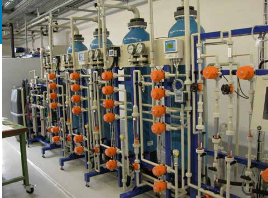
einer realisierten Ionenaustauscheranlage
