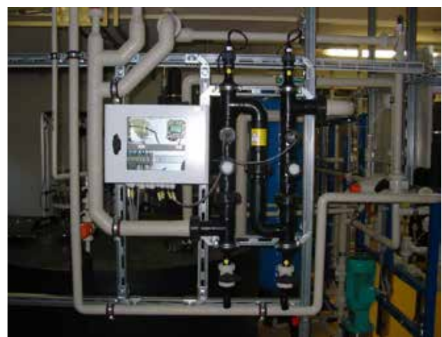
Bild einer UV-Entkeimung mit Überwachung für die Medizintechnik
