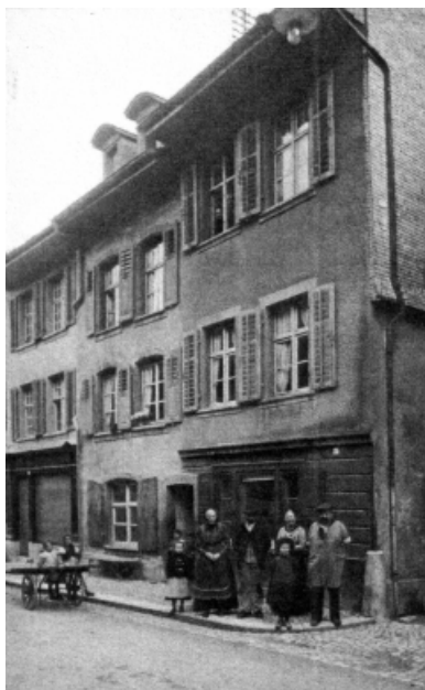
Auf dieser Aufnahme sind die Gründer Firma (Ur-Grosseltern von Reinhold und Rolf Tschopp) vor ihrem Geschäftshaus
